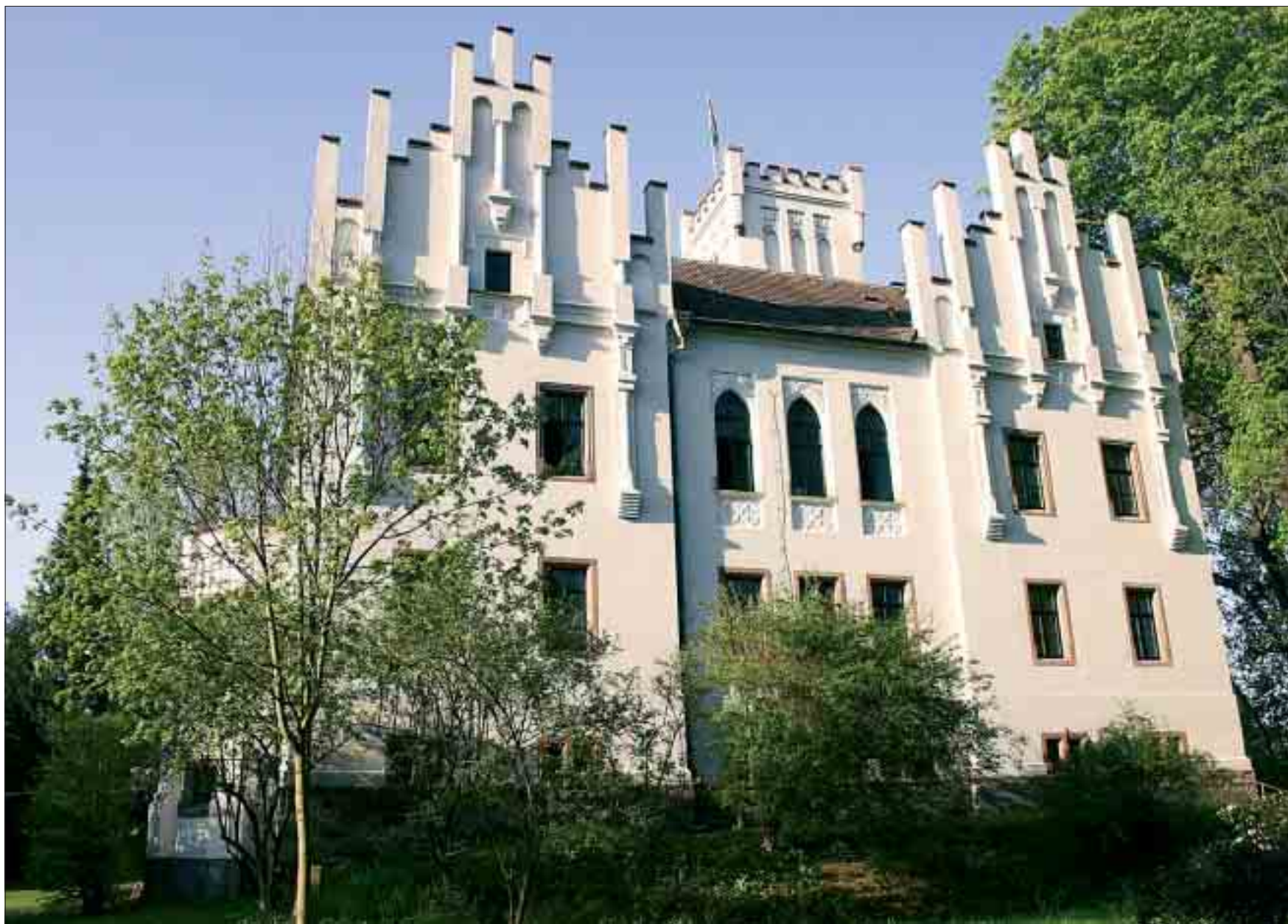
Bei der Restaurierung des Firmensitzes „Schloss Steinpleis“ hat Immobilienfan Dr. Frank André Audilet sogar selbst Hand angelegt.
